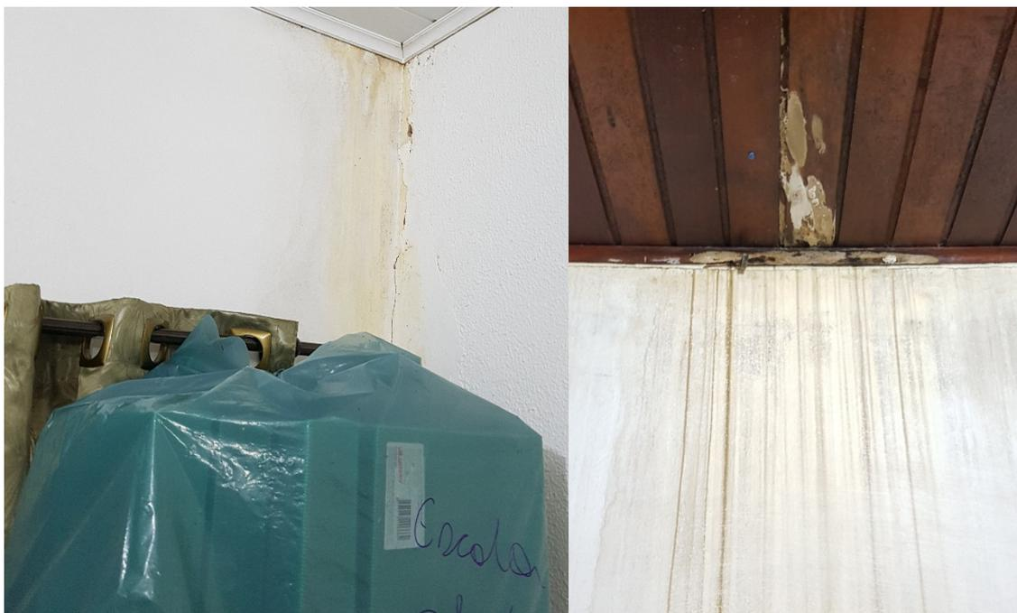
Dois dos locais que apresentam infiltrações, colocando em risco todos os equipamentos de informática e outros nos locais das infiltrações.
