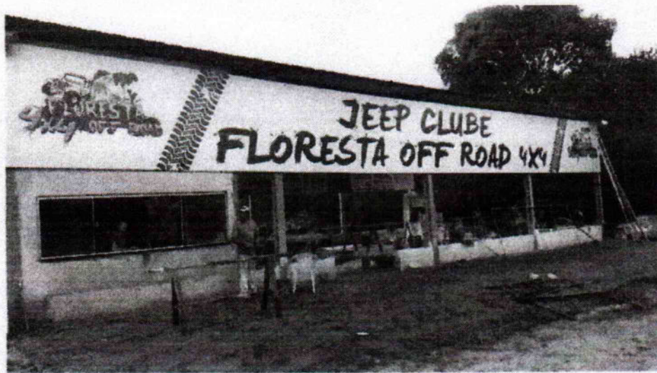
Construção da sede social, Alta Floresta – MT
